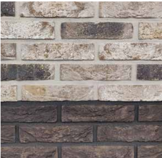
Metselwerk licht grijs genuanceerd met donkere plint
