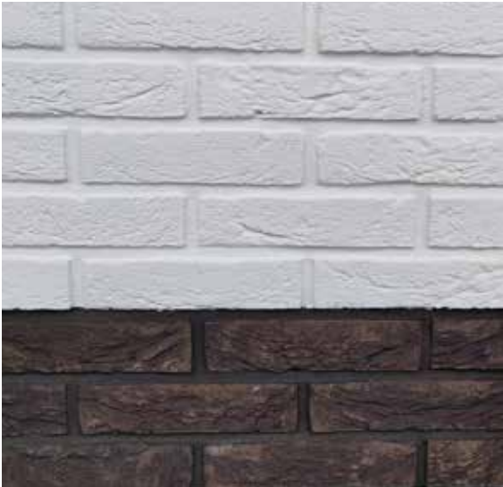
Metselwerk wit gekeimd met donkere plint
